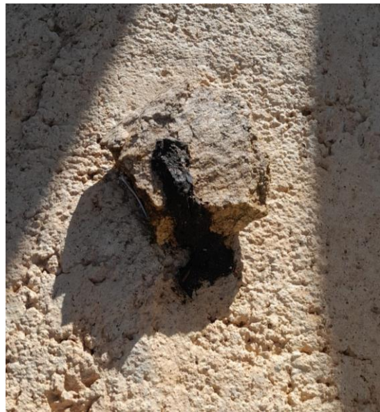
Figura 23: Rastre de carnívor sota un suport elèctric. Font: pròpia
