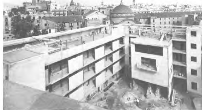
Vista de conjunto del Dispensario en construcción. Foto Arxiu Mas.
