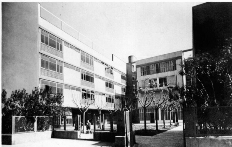
El Dispensario en construcción. 1935. Foto Arxiu Mas. Vista desde el patio. Foto Arxiu Mas.
