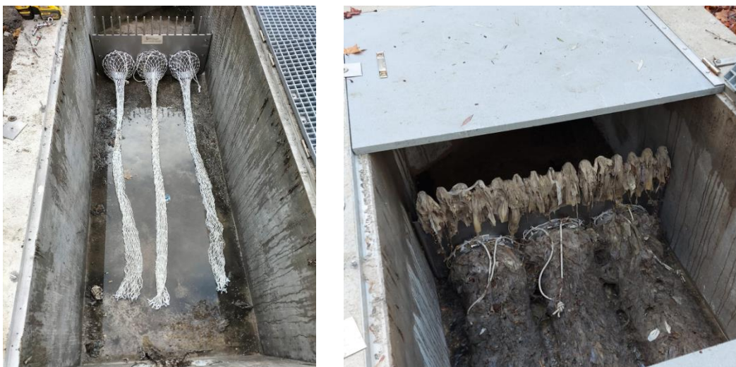
Figura 3. Sacs filtrants nous (esquerre) i usats (dreta) del sobreeixidor del Pont de l'aigua. Font.
