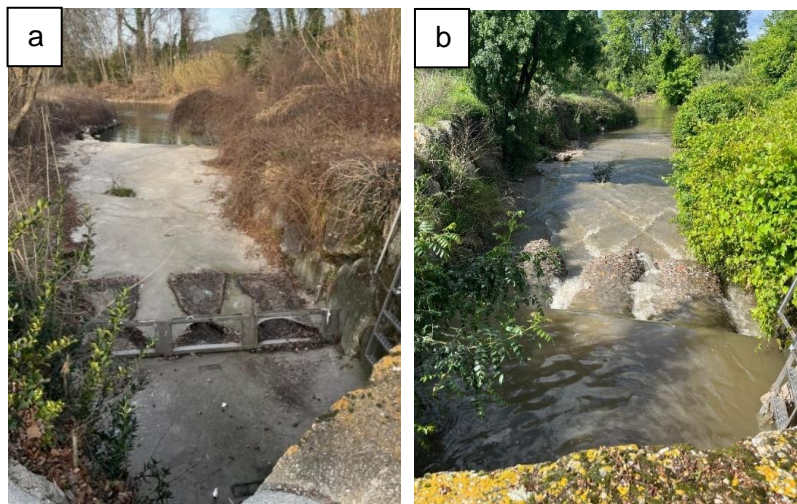
Figura 11. Estat del sobreexidor del Trueta a temps sec, el 30 de gener (a) i en època de pluges, el 14 de maig (b).
