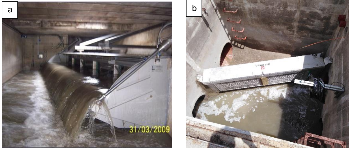
Figura 4. Reixes auto-netejables d'obertura variable (a) i d'obertura contínua (b). Font: TRARGISA
