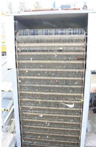
Figura 5. Reixa de sòlids fins similar a les que hi dins una estació de bombeig. Font: ACA
