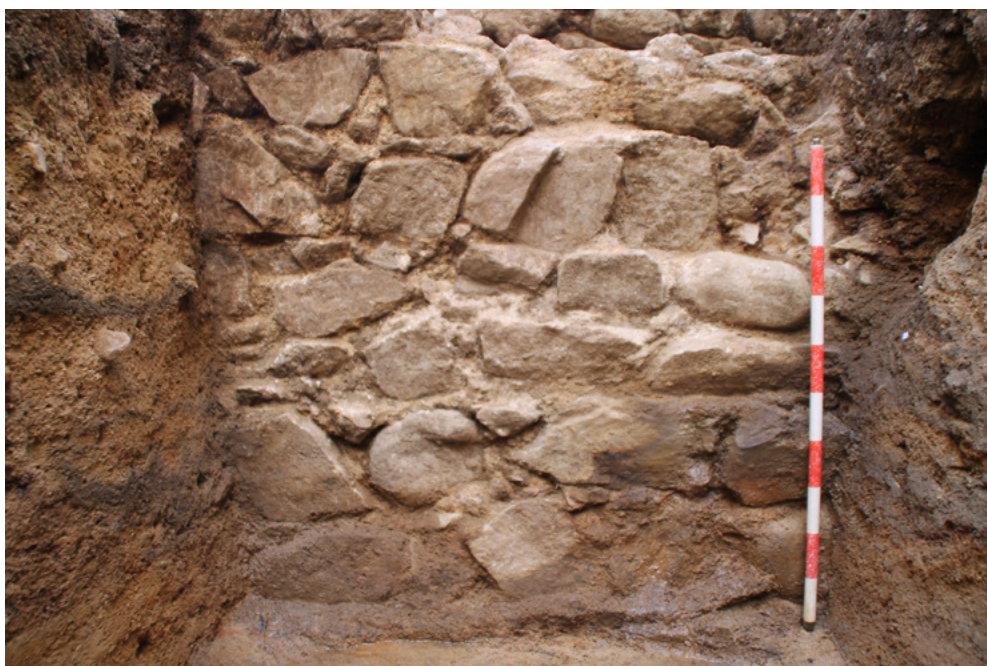
Figura 12. Parament interior de l'estructura UE 2008.
