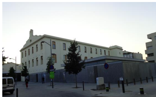
L'edifici de la Marfà on hi ha la Biblioteca Municipal Salvador Allende.
