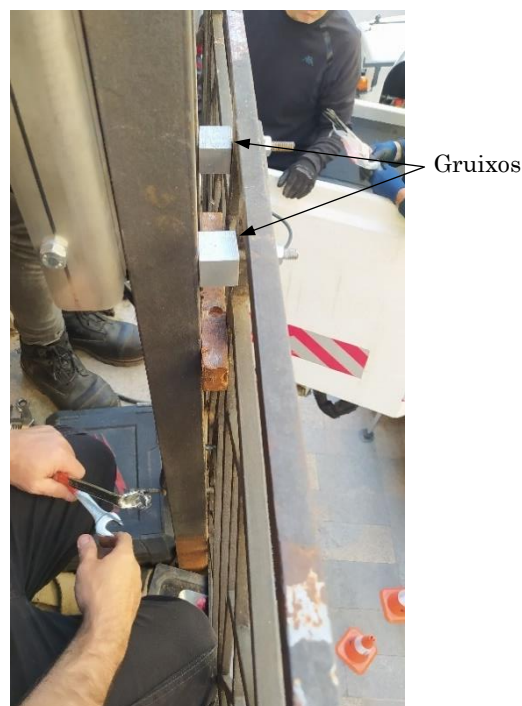
Figura 75: Detall gruix de la barana
