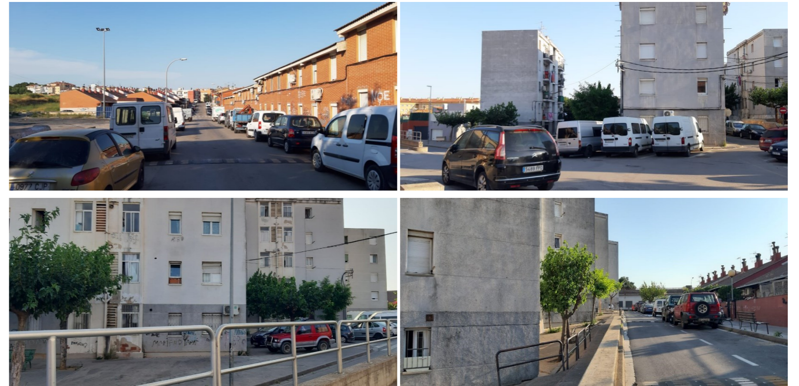
Imatges 1-4: Barri del Culubret, habitatges PB+1 i edificis de fins a PB+4. Fons propi
