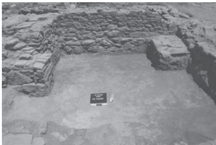
Figura 3. Àmbit en el qual es va rebaixar el nivell de circulació per col·locar un nou paviment. Es pot apreciar com amb el morter del paviment es va folrar la part inferior del mur nord que marca un canvi de cota en la pavimentació i com la façana (dreta) va quedar penjada.
