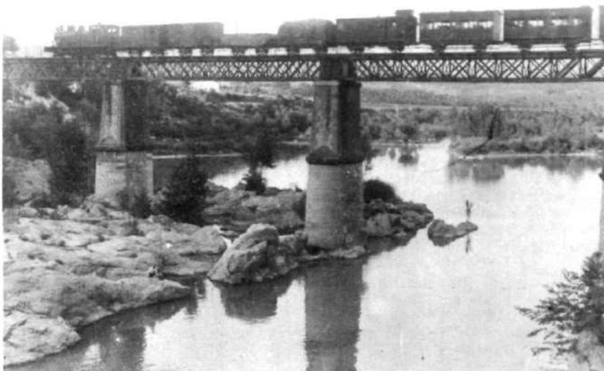
El tren travessant el pont del Pasteral, una de les gran obres d'enginyeria de la línia
