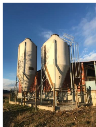
Figura 22: Dipòsits de pinso, explotació Santa Eularieta. FONT. Elaboració pròpia.
