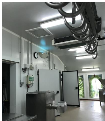
Figura 49: Obrador Cal Rovira. FONT. Elaboració pròpia.
