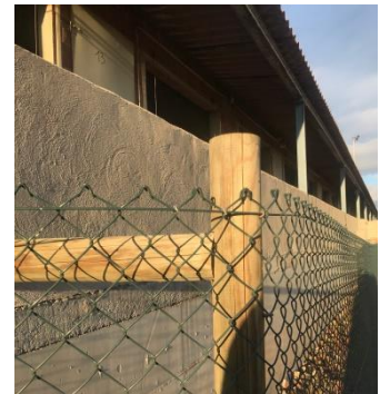
Figura 26: Perímetre tancat, explotació Santa Eularieta. FONT. Elaboració pròpia.
