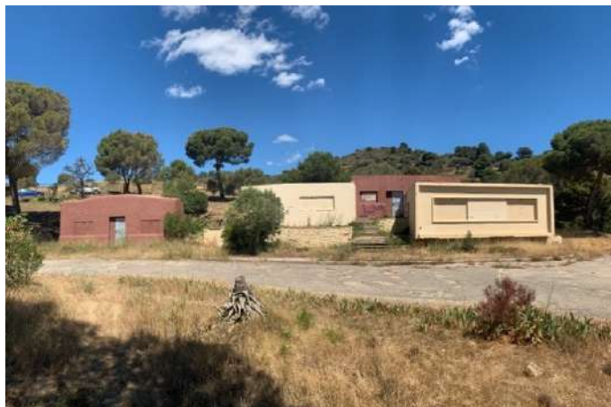
Foto panoràmica de l'edificació on s'hi situaria el punt d'informació.
