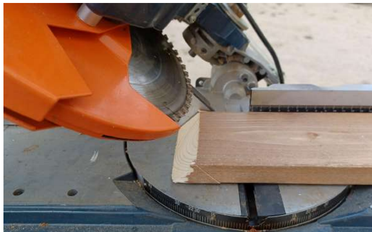
Imatge 50: Serra circular mecànica tallant un tros de la fusta de pi base per fer-ne el pont del monocordi.
