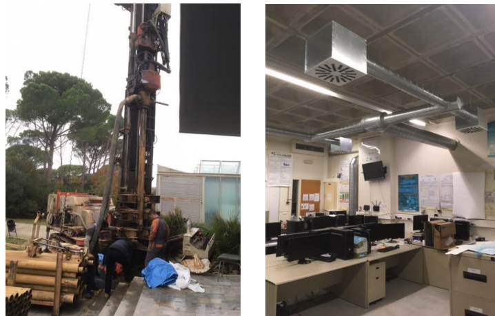
Figura 2.8: A l'esquerra, obres de construcció del pou de geotèrmia. A la dreta, sistema de ventilació visible al sostre del living lab. Font: eXiT
