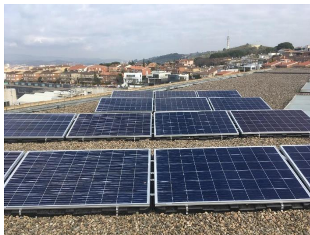
Figura 2.1: Instal·lació dels panells d'energia fotovoltaica a la teulada de l'edifici P-IV de la UdG
