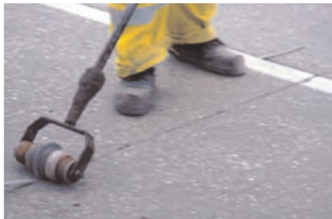
Figura 138: Imatge instal·lació d'obturgador en el fons del tall. Font: Norma 6.1 – IC
