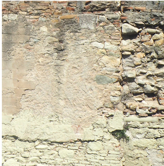
Casa Miralles, estat actual.
