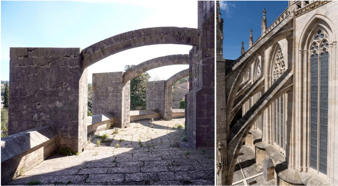
Figura 50. A la izquierda, fotografía de los arbotantes de la Catedral de Girona. A la derecha, fotografía de los arbotantes de la Catedral de Narbona. A pesar de sus influencias geográficas, históricas y constructivas, se observan grandes diferencias formales; además, los arbotantes de Narbona –a diferencia de los de Girona– desempeñan la función de canalizar las aguas pluviales. Imagen realizada por el autor.
