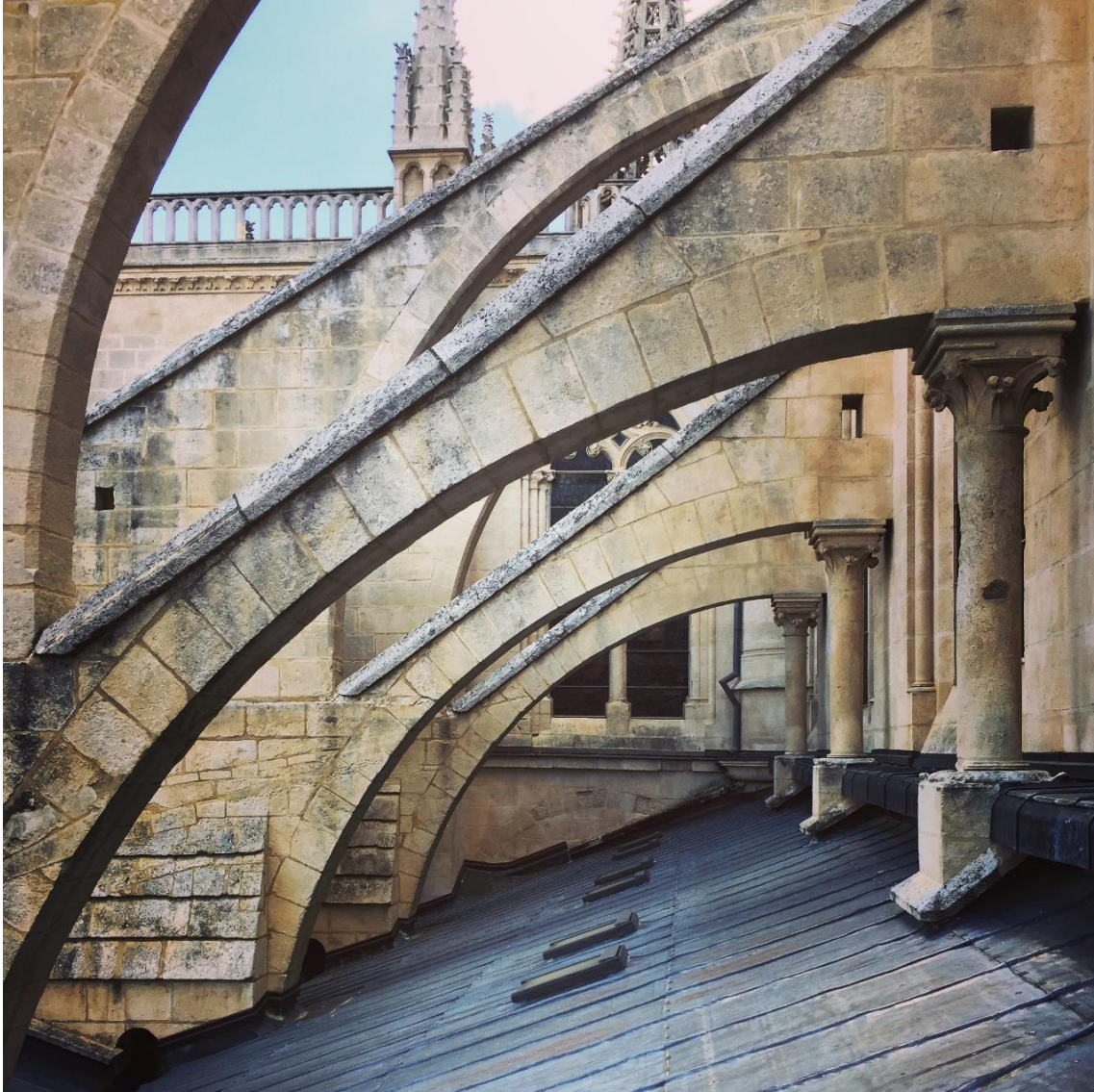
Figura 9. Fotografía de los arbotantes de la Catedral de Burgos. Fotografía realizada por el autor.
