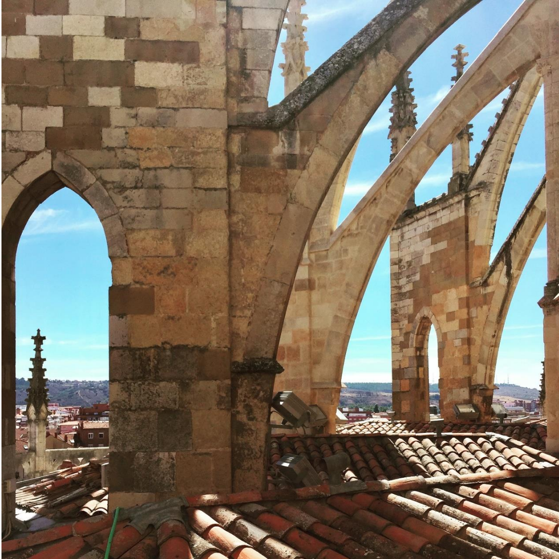
Figura 11. Fotografía de los arbotantes de la Catedral de León. Fotografía realizada por el autor.
