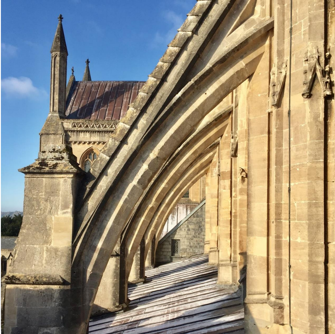
Figura 27. Fotografía de los arbotantes de la Catedral de Wells. Fotografía realizada por el autor.
