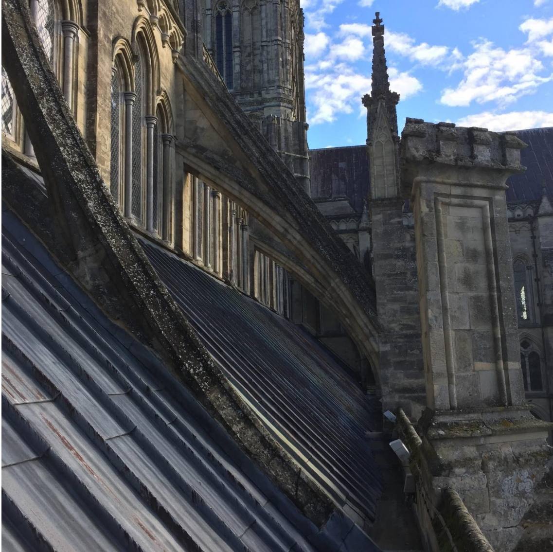
Figura 25. Fotografía de los arbotantes de la Catedral de Salisbury. Fotografía realizada por el autor.
