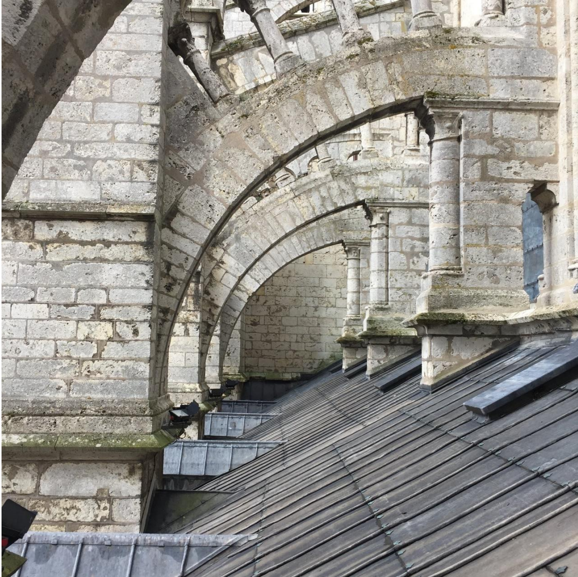
Figura 17. Fotografía de los arbotantes de la Catedral de Chartres. Fotografía realizada por el autor.
