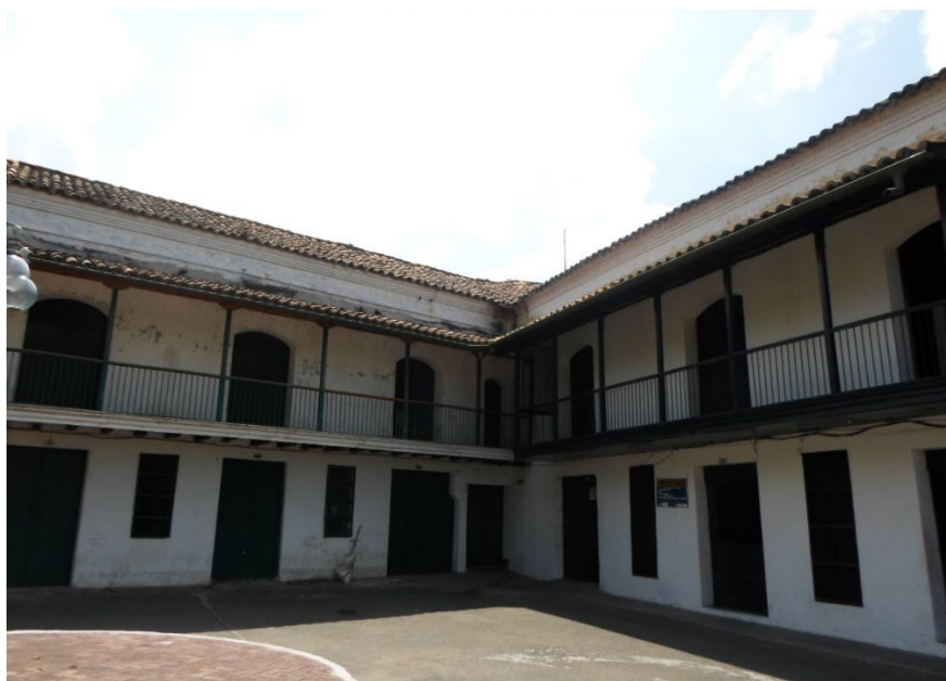
Figura 32 Construcción histórica en deterioro.
