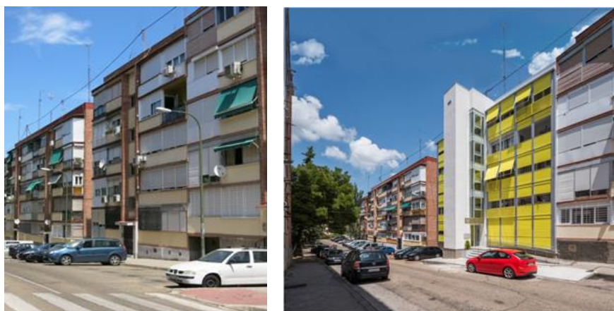
Fig. 5 Imatge prèvia i posterior a la rehabilitació. Font: Bher Arquitectos (2018)
