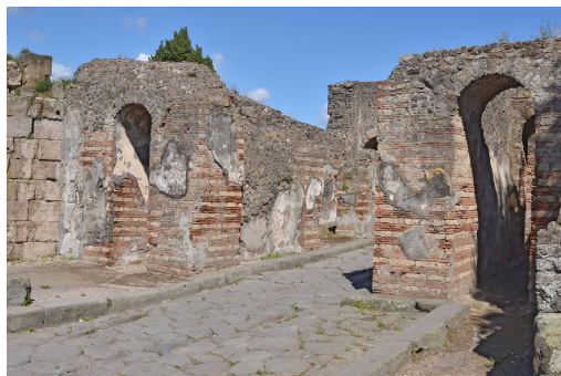
Figura 1 Construcció romana amb peces de ceràmica vista. Font: Brickarchitecture (2017)
