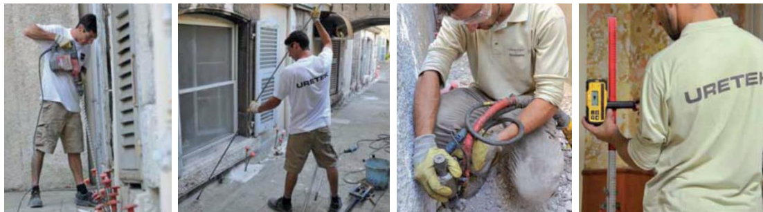
Fig. 13. Procediment de les injeccions de resina. D'esquerra a dreta. Perforació, col·locació dels tubs d'injecció, injecció de la resina i monitorització làser, comprovació dels resultats amb assaig de penetració. Font: Uretek
