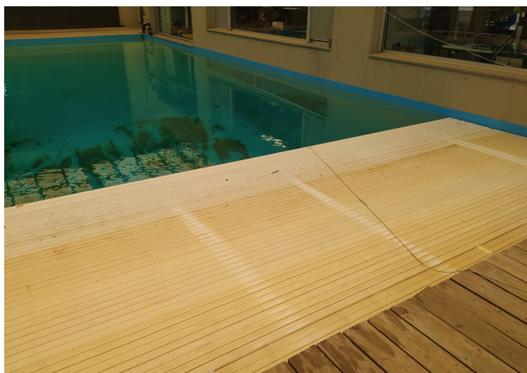
FIGURA 8.7: Cortina de la piscina del CIRS tapant la zona de treball
