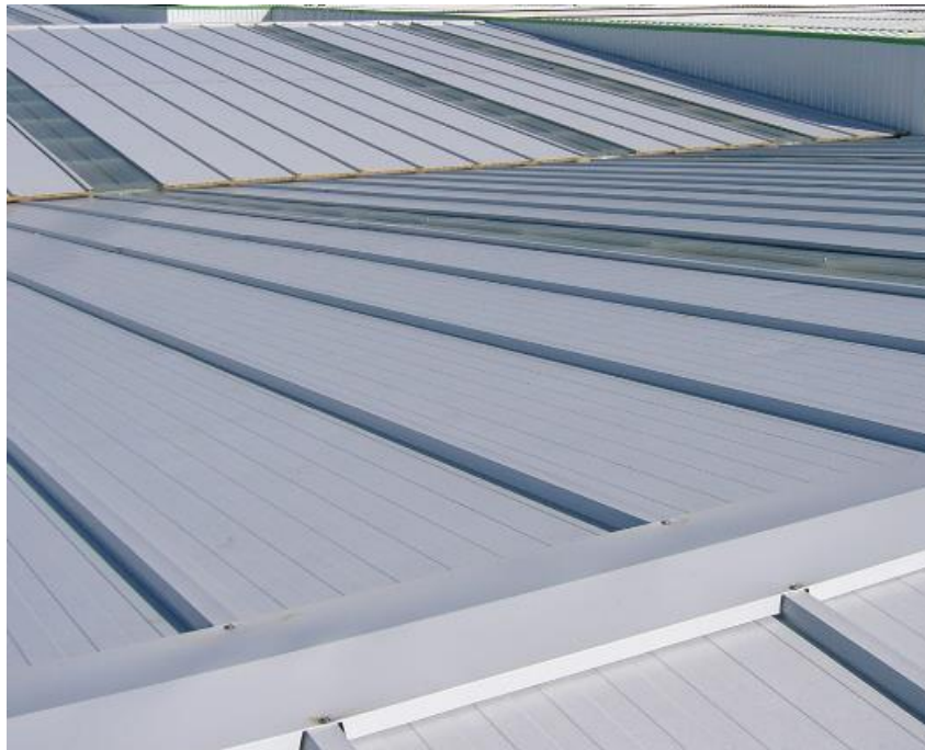
Figura 2: Detall tipus coberta
