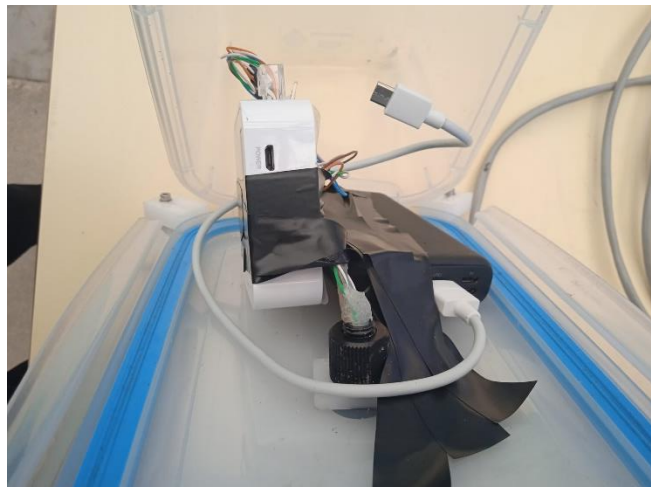
Figura 90. Taper obert per poder connectar el cable d'alimentació al router.
