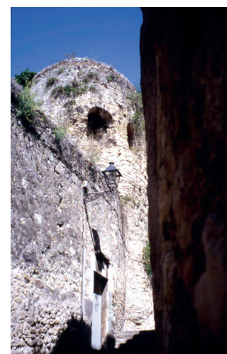
Figura 6. Torre núm. 8 (o vescomtal). a) Vista exterior. b) Vista interior.
