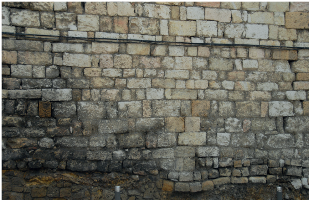
Figura 21. Tram de muralla a la via de l'Imperi romà, formada per filades de carreus de llarg i través, de petites dimensions i cronologia incerta.
