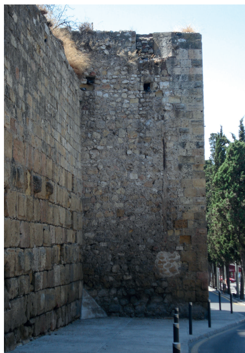
FigURA 33. Torre del Tintorer.
