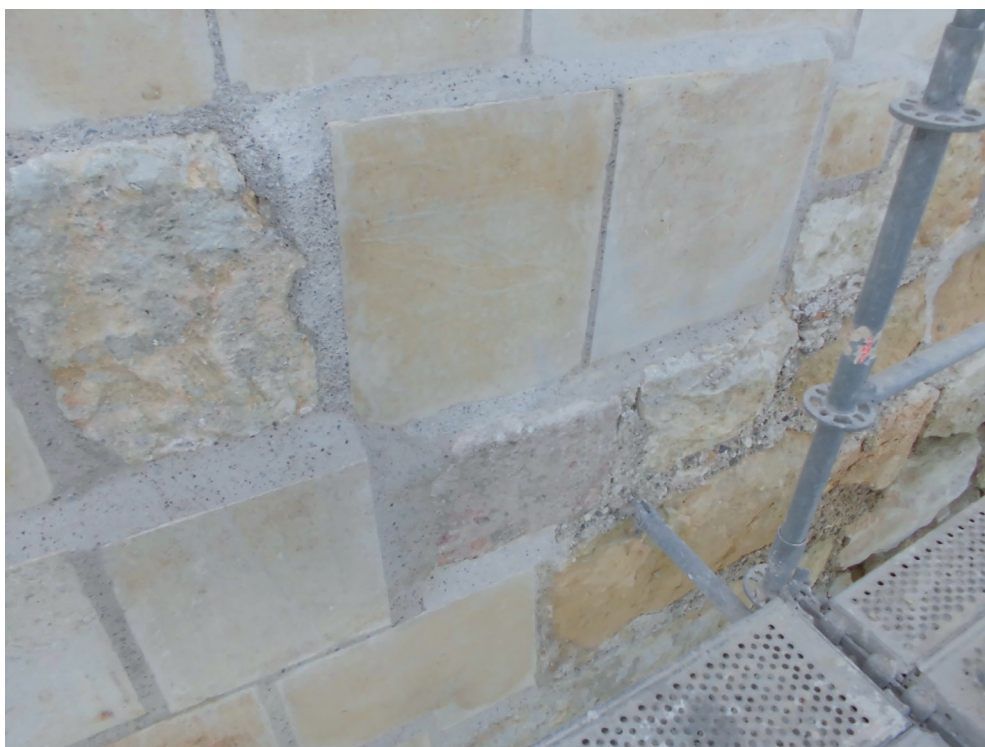
Figura 15. Esgraonat de carreus de la reparació medieval a l'exterior del pany del col·legi Lestonnac.
