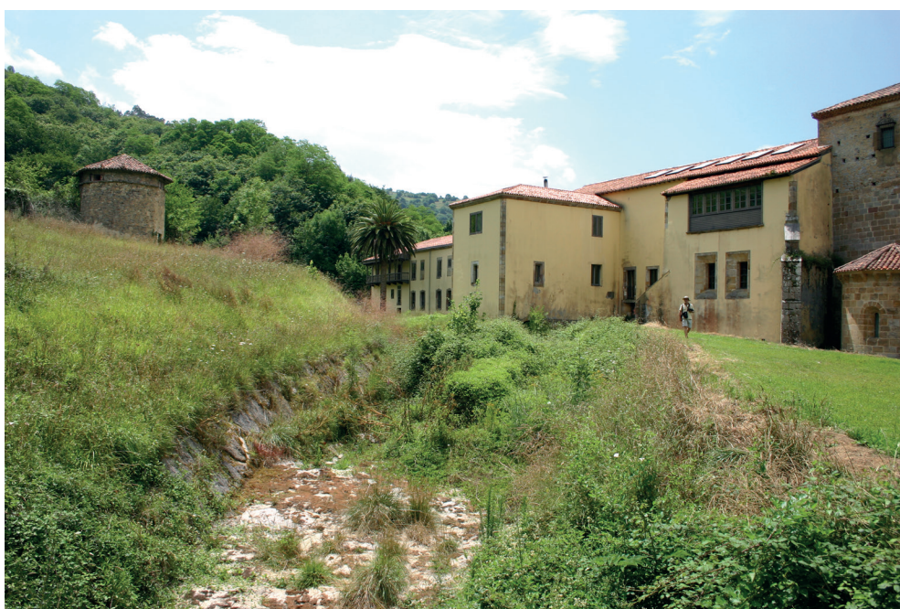
Figura 8. Reunificación de los canales (revestidos de lastrones) tras superar la letrina y la quilla de salida.
