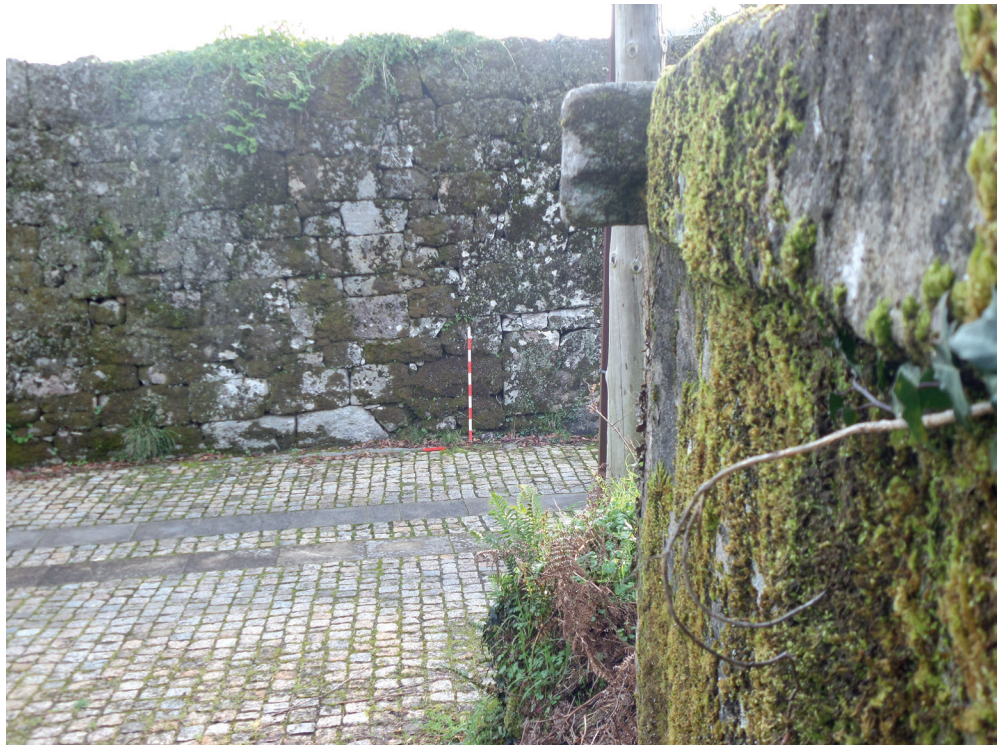
Figura 11. Melón. Huella del paso del agua cruzando la cerca monástica, después amortizada.
