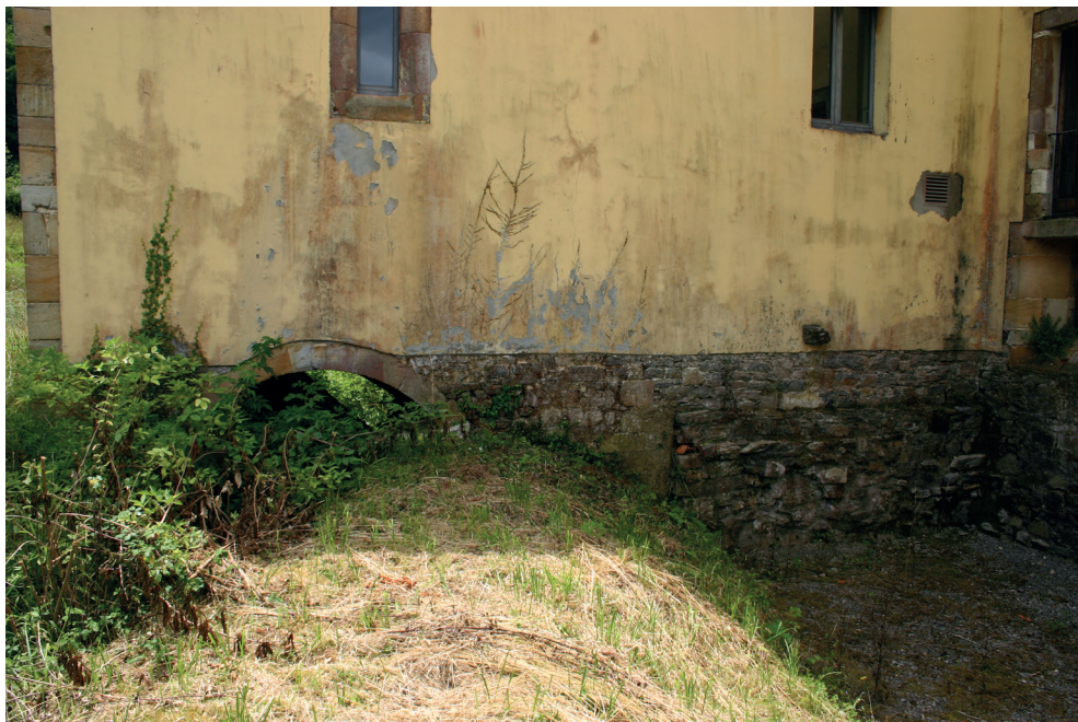
Figura 7. Canal de la letrina de Valdediós y fases constructivas en el muro.
