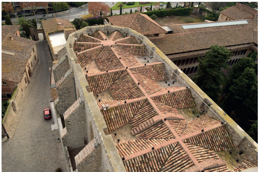
Figura 4. Vista parcial de la coberta de l'església del monestir de Pedralbes. És, de les esglésies gòtiques barcelonines, la que conserva la fesomia més propera al seu acabat medieval original, tot i els arranjaments i les reparacions fetes l'any 2000.
