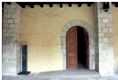
Figura 5. Detall de l'actual porta d'accés al refectori des del claustre. Podem observar com el contrafort del costat del pas cobreix (tapa) alguna de les peces del muntant de la porta, tot indicat la seva manca de sincronia constructiva; és a dir, que la paret i els contraforts no s'aixecaren alhora.
