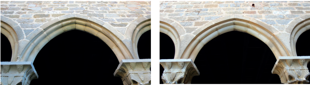
Figura 15. Dos detalls dels arcs de les galeries de la planta del claustre. A l'esquerra, del pòrtic del costat del refectori; a la dreta, de la galeria del costat de l'església. Notem la diferència en el nombre de dovelles que configuren els arcs i que identifiquen fases constructives dissemblants; més moderna la corresponent a la banda de l'església.
