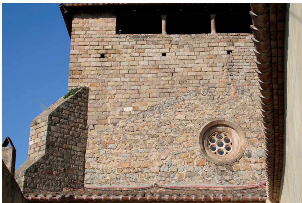
Fig. 12. Detall de la façana de la sala capitular que s'obre vers orient. Hom pot distingir el parament de carreus de la construcció original associat a la petja d'una coberta de vessants (c. segle XIV). També s'observa el parament dels contraforts del segle XV i el mirador del segle XVI.
