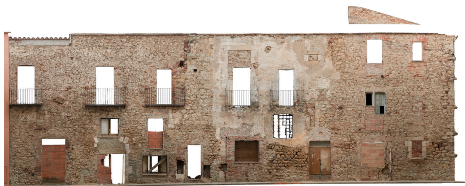
Figura 19. Aixecament fotogramètric un cop retirats els revestiments actuals de a façana exterior de l'ala sud del claustre del monestir. FEB/2022 (E. Piriz-Captae Digitalizado 3D).
