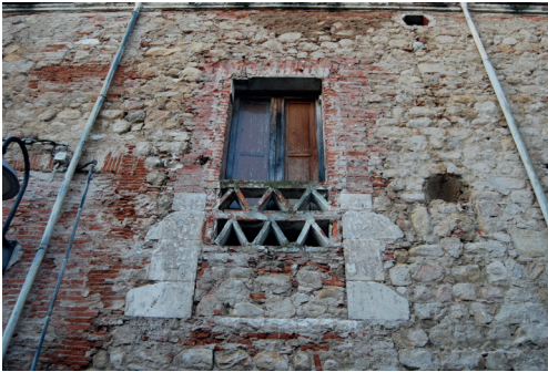
Figura 17. Imatge de la façana interior de l'ala sud del claustre del monestir on es poden veure (fletxes vermelles) les dues arestes formades per carreus que delimiten a banda i banda un volum edificat sobresortint. 17/NOV/2021 (E. Píriz).
