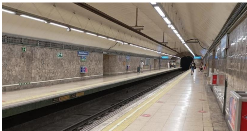
Imatge 74. Andana de l'estació de metro de Manuel Becerra, L6, Madrid.
