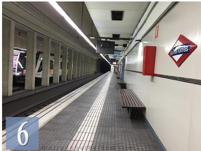
Imatge 60. Andana de l'estació de metro de Les Tres Torres, L6, Barcelona.
