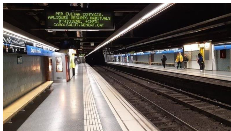
Imatge 58. Andana de l'estació de metro de Sagrada Família, L5, Barcelona.
