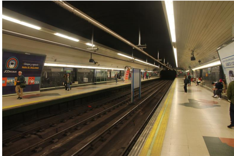
Imatge 75. Andana de l'estació de metro de C. Universitaria, L6, Madrid.
