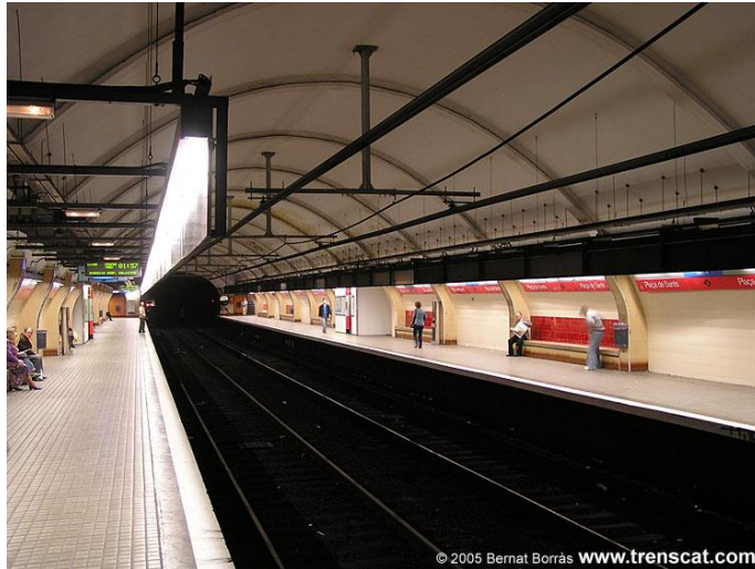
Imatge 50. Andana de l'estació de metro de Plaça de Sants, L1, Barcelona.
