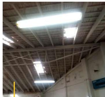
**Figura 2.** Vista de los techos altos de estructura de madera de uno de estos talleres
