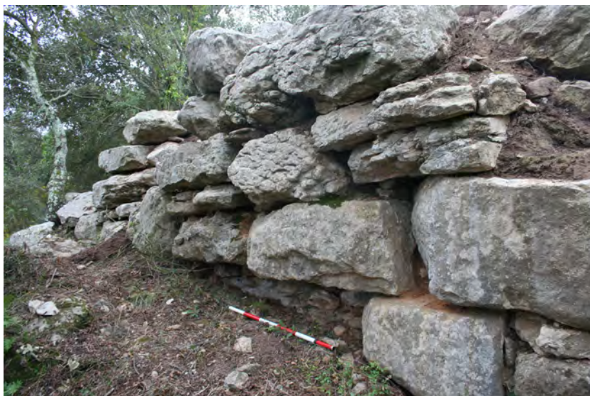
Fig. 5. Fonamentació del mur MR 1005 sobre la roca mare.
