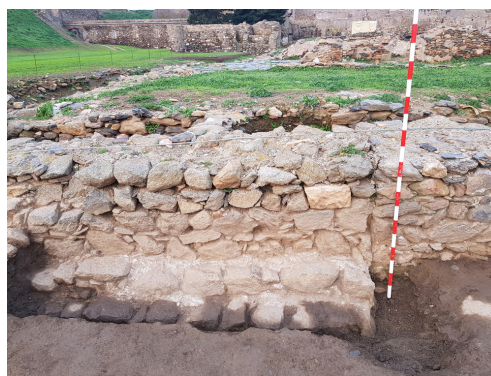
Fig. 13.- Tram sud est de la muralla baixmedieval, on s'aprecia el canvi en la tècnica constructiva.
