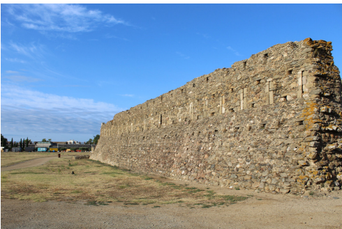
Fig. 12.- Tram de muralla amb escarpa.
