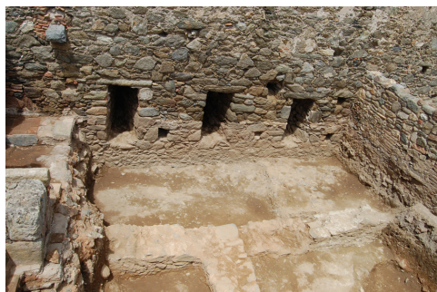
Fig. 14.- Muralla oest de la vila, on s'aprecien les espitlleres i el carreró que la separava de l'illa de cases.
