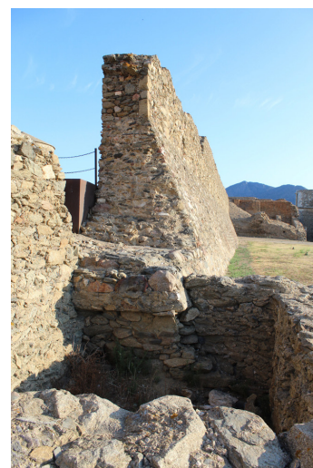
Fig. 9.- La torre quadrangular H es va bastir contra el mur amb escarpa.
