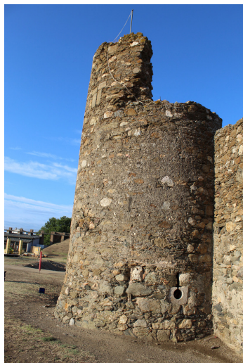
Fig. 16.- Espitllera per armes de foc a la part baixa de la torre F.
