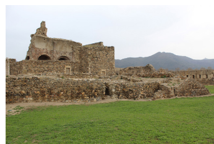
Fig. 4.- Tram sud del mur del monestir, amb un tram amb opus spicatum (esquerra). A la dreta les restes de la doble escala moderna.
