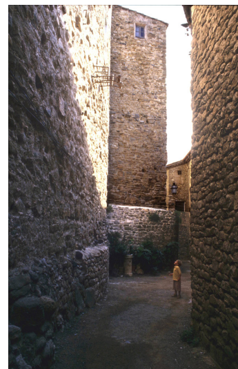
Fig. 4. Aspecte de la muralla i d'una de les torres altmedievales des del carrer Rocafort.
