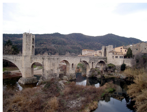
Fig. 7. Vista del pont amb les torres.
