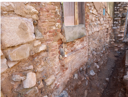
Fig. 10. Vista de l'arrasament de la cara interior de la muralla medieval previ a la reconstrucció del mur. La part enderrocada s'incorpora a l'amplada del corredor perimetral. Foto: Josep M. Vila.
