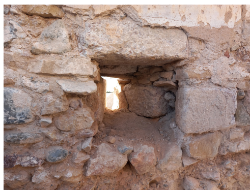
Fig. 11. Detall d'una de les espitlleres construïdes en el marc de la refacció de la muralla després de la Guerra dels Segadors. Foto: Josep M. Vila.
