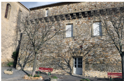
Fig. 21. Saint-Pons-la-Calm. Vue extérieure de la courtine MR2, front ouest. © F. Loppe, 2022.
