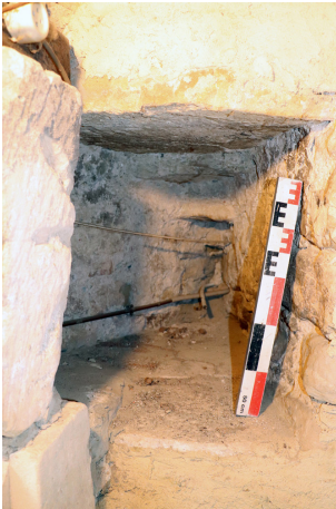
Fig. 27. Saint-Pons-la-Calm. Mur MR4, parement intérieur ouest. Vue détaillée de l'ouverture de tir. © F. Loppe, 2022.
