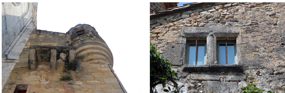
Fig. 16. Saint-Laurent-la-Vernède. Vue de l'échauguette ECH1 édifiée sur l'angle nord-ouest du fort. À gauche, une latrine en encorbellement autrefois accessible depuis le chemin de ronde par une porte aujourd'hui bouchée. © F. Loppe, 2021.
