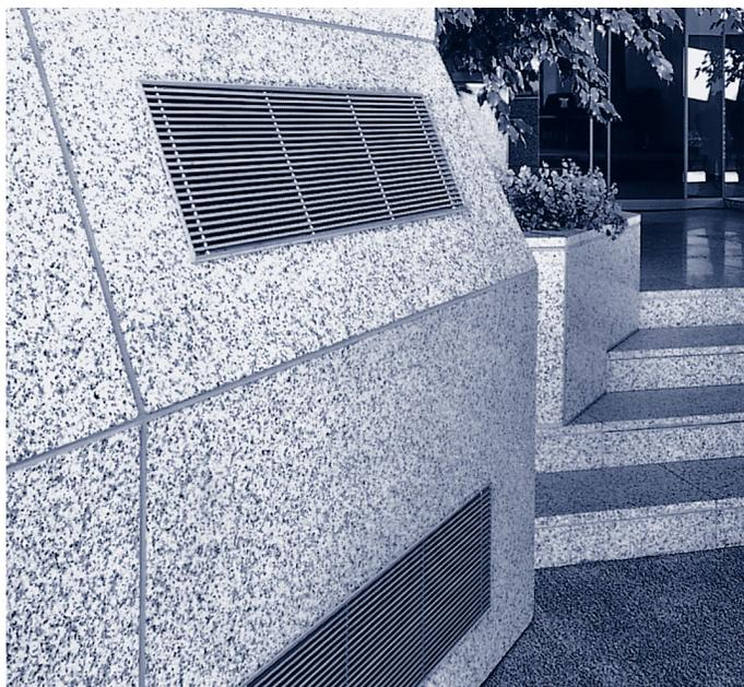
Las rejillas y las rejillas continuas se emplean como unidades terminales para la ventilación de edificios y espacios para la impulsión y retorno del aire.
