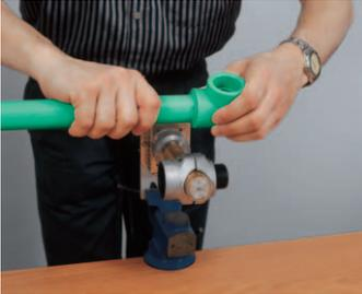
9/ Después de haberse terminado el período de calentamiento, sacamos el accesorio y el tubo de la matriz, y los unimos de forma tal, que con una moderada, lenta y uniforme presión, los introduzcamos, sin rotación del eje, al manguito del accesorio hasta el tope del acoplamiento. Controlamos la unión del eje del tubo con el accesorio.
