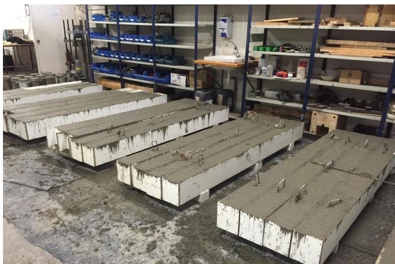
Figura 32: Formigonat dels espècimens
