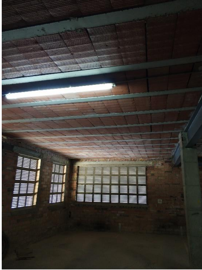
Fig.4 Vista del garatge inferior a la localització de l'estructura
