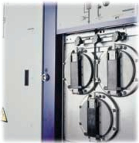
Tubos portafusibles de 36 kV
