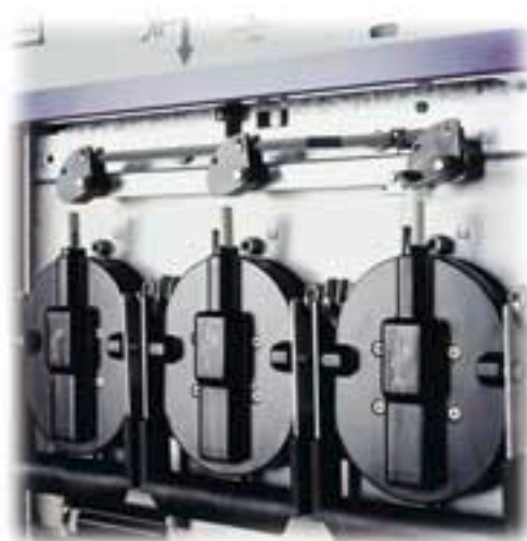
Tubos portafusibles de 12/24 kV
