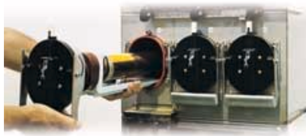
Carros portafusibles CMP-F 24 kV
