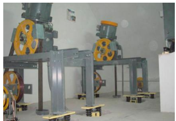
Figura 4: Aïllant acústic de llana mineral a la esquerra i amortidors per limitar vibracions i impactes als motors del elevador a la dreta
