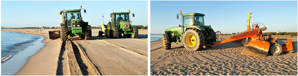
Figura 5: Allanamiento mecánico de la playa de Sant Pere Pescador. Los barjanes son destruidos de forma artificial cuando llega la temporada de verano a pesar de presentar más valores geomorfológicos que el LIG adyacente. Fuente: Empresa de servicios Can Pipa.
