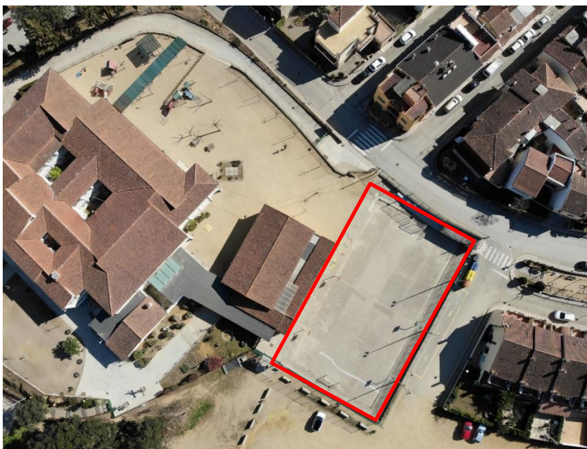
Fig. 1: Vista aèria de la pista poliesportiva a cobrir
