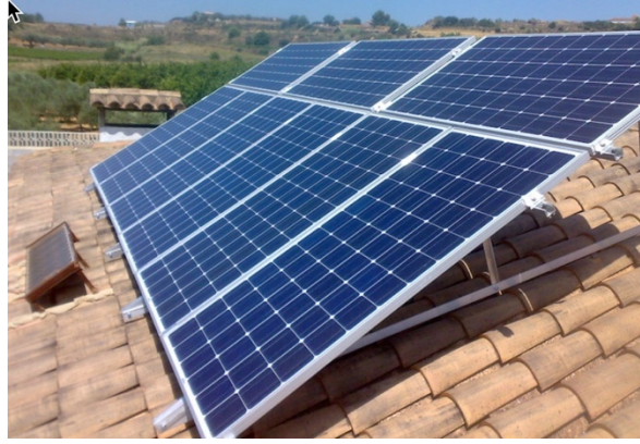
Figura 9. Fixació captadors solars inclinats. Font: AutoSolar Energy Solutions. Valencia.
