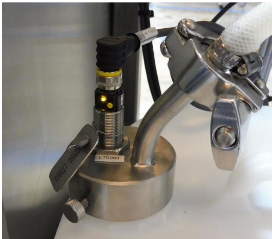
Figura Annex 110: Sensor de nivell del dipòsit del detergent, Liquiphant FTL33
