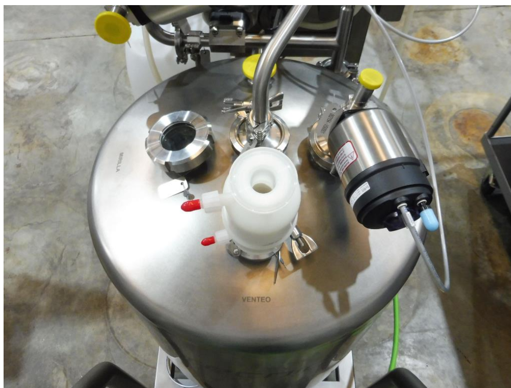
Figura Annex 95: Tapa del dipòsit pulmó
