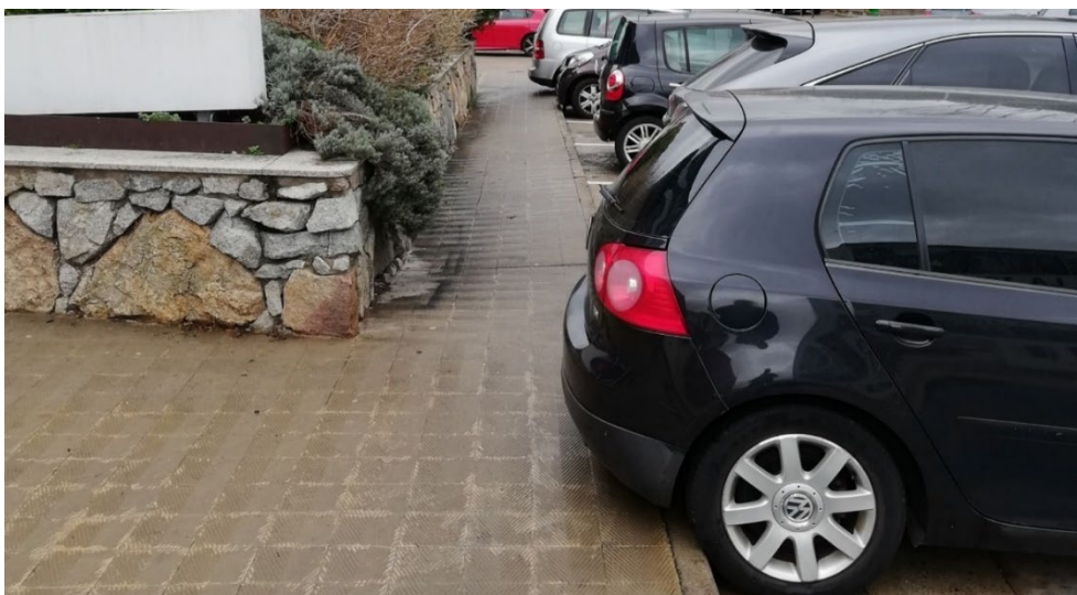
Imatge 24: Estat actual de la vorera de l'avinguda Pau Casals núm. 60 que es proposa ampliar. Font: pròpia
