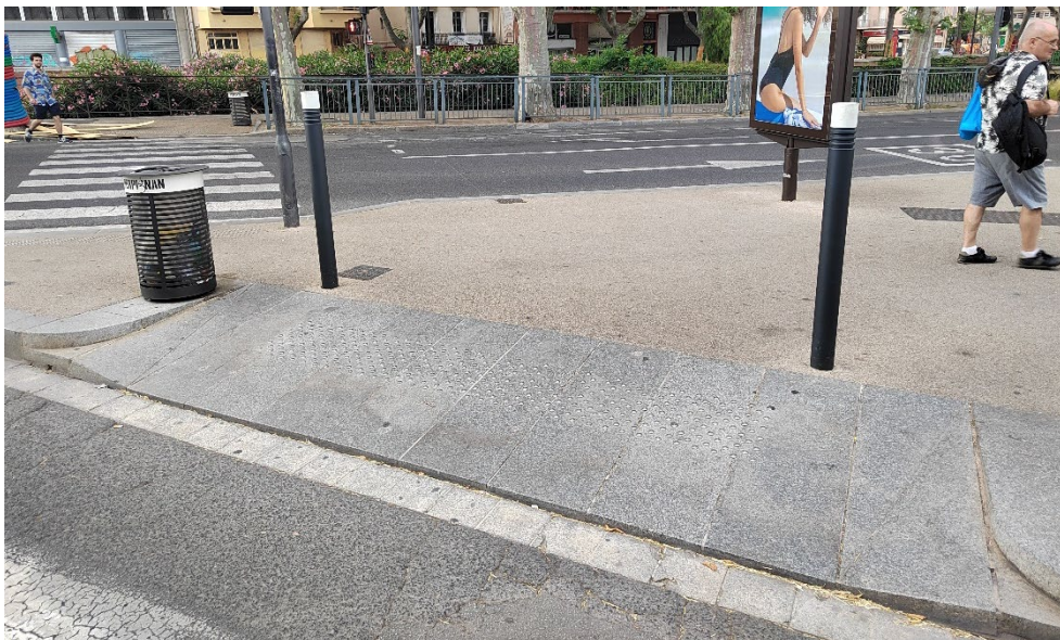
Imatge 11: Gual de vianants a Perpinyà executat segons normativa francesa. Font: pròpia
