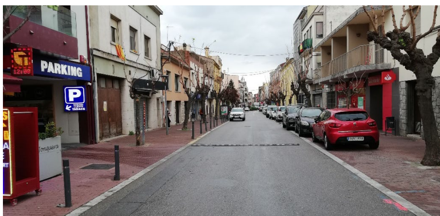
Imatge 10: Exemple de zona de plataforma única amb espai de trànsit compartit entre vianants i vehicles al Carrer Major. Font: pròpia.
