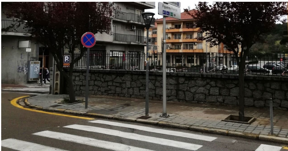
Imatge 31: Pas de vianants amb obstacles a l'avinguda Pau Casals. Font: pròpia
