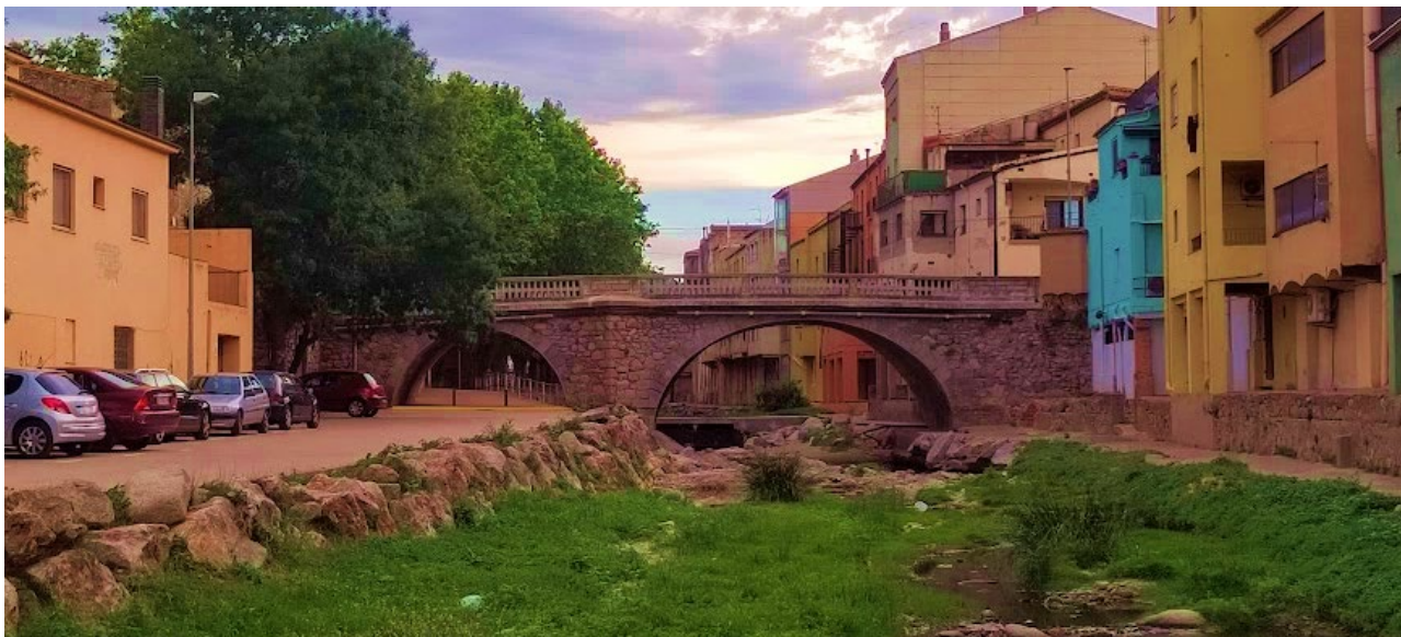
Figura 2: Pont vell del Carrer Arias Comellas sobre el que es realitza una part del treball.
