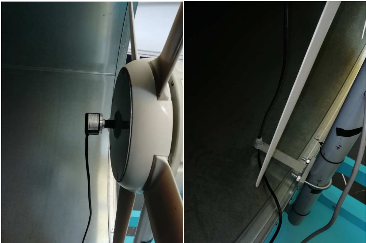
Figura 14. Instal·lació de l'encoder incremental E40S6-1024-6-L-5 a l'aerogenerador.
