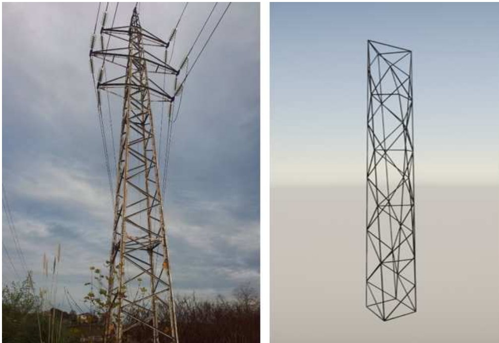
Figura 15. Torre elèctrica amb triangulació tipo Warren – Estructura monòlit
