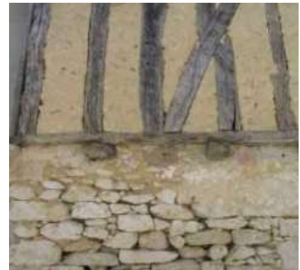
Figura 7: Habitatge etrusca de 400 aC, murs de petits maçoneria reforçats amb fusta, o filades de tova, revestides amb fang. Font apunts d'Història de construcció.
