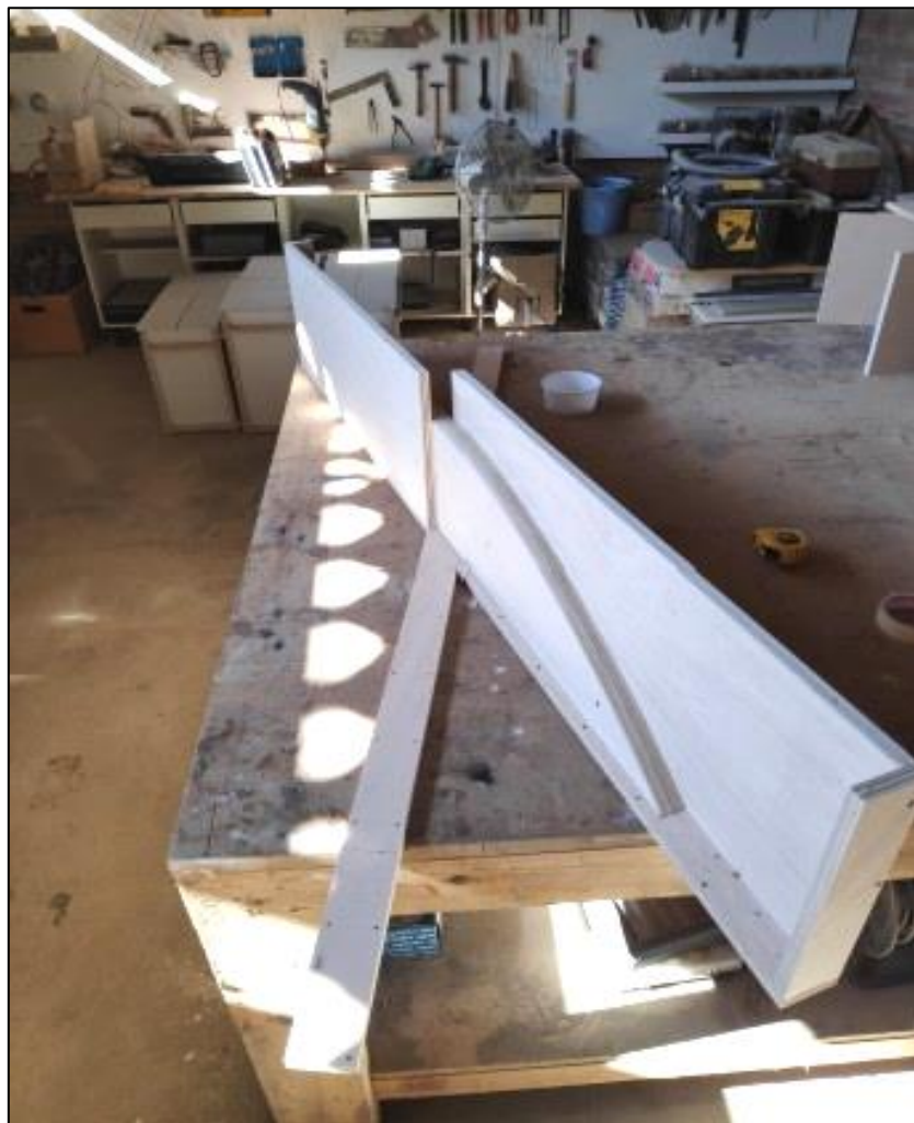
Imatge 19: Muntatge de l'encofrat (2).
