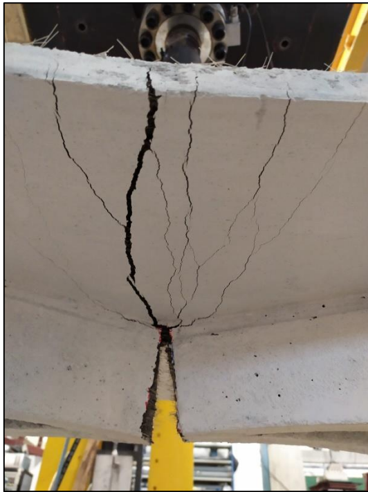
Imatge 48: Estat previ al trencament total.
