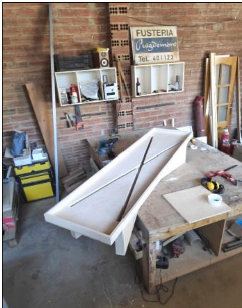
Imatge 21: Muntatge de l'encofrat (4).
