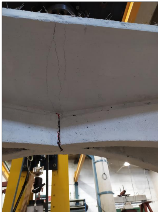
Imatge 44: Aparició de fissures en el taulell superior.
