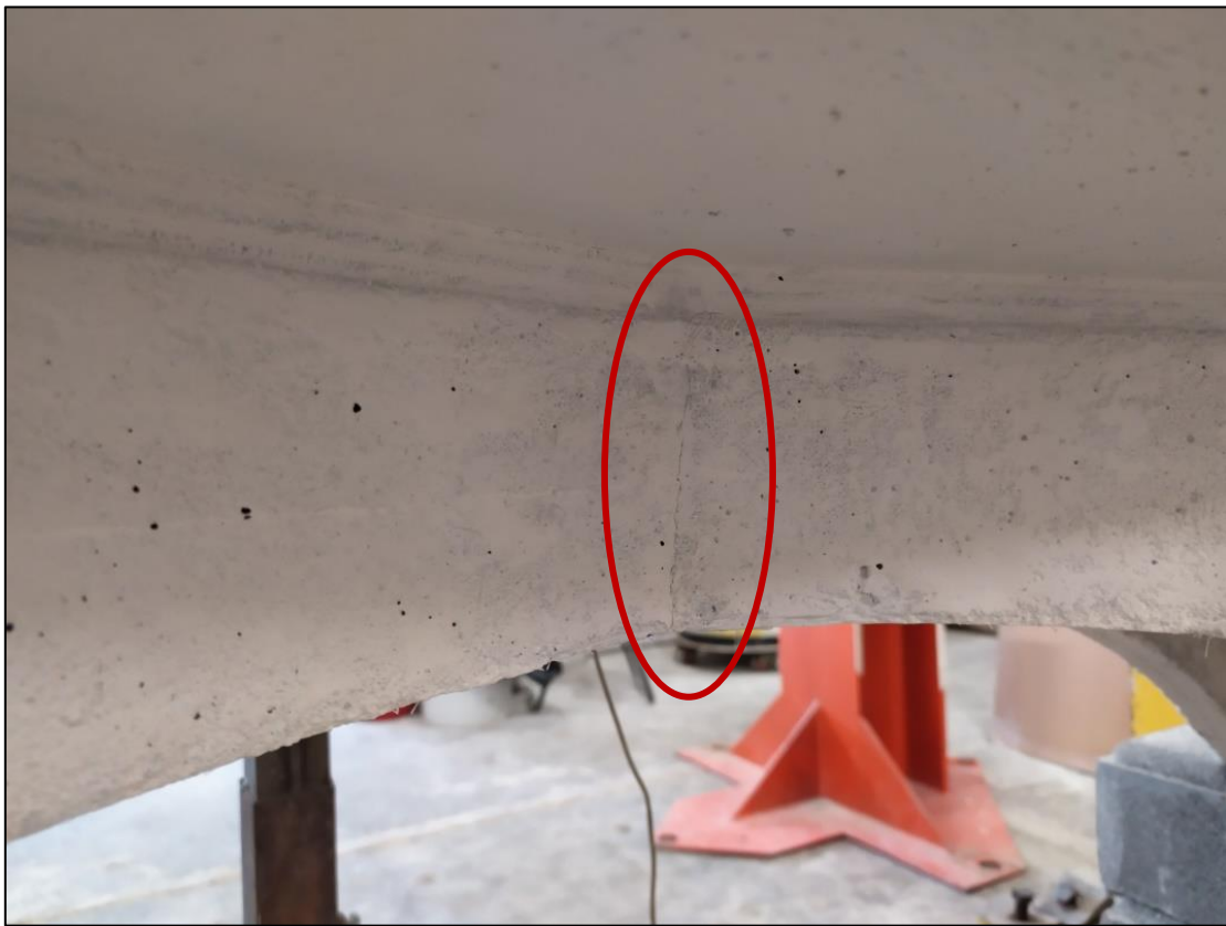
Imatge 41: Aparició de la primera fissura.
