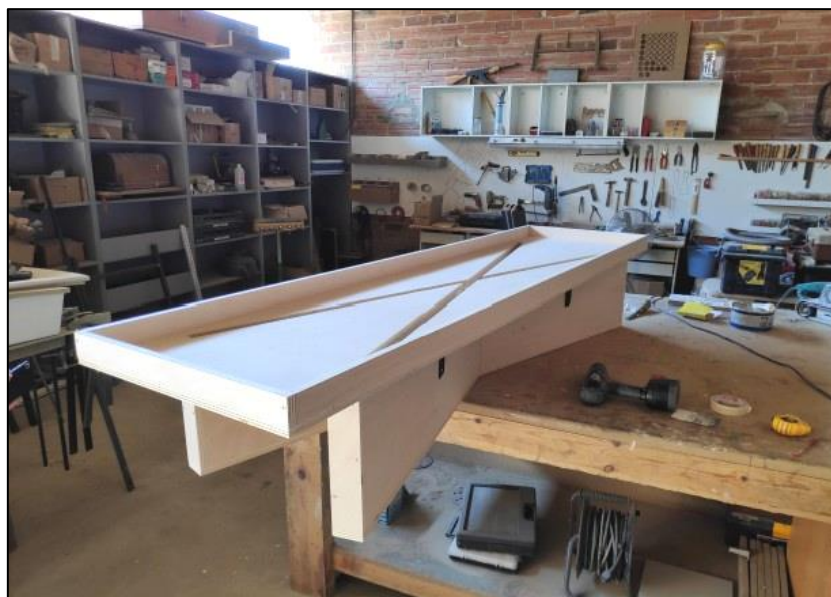
Imatge 22: Muntatge de l'encofrat finalitzat.
