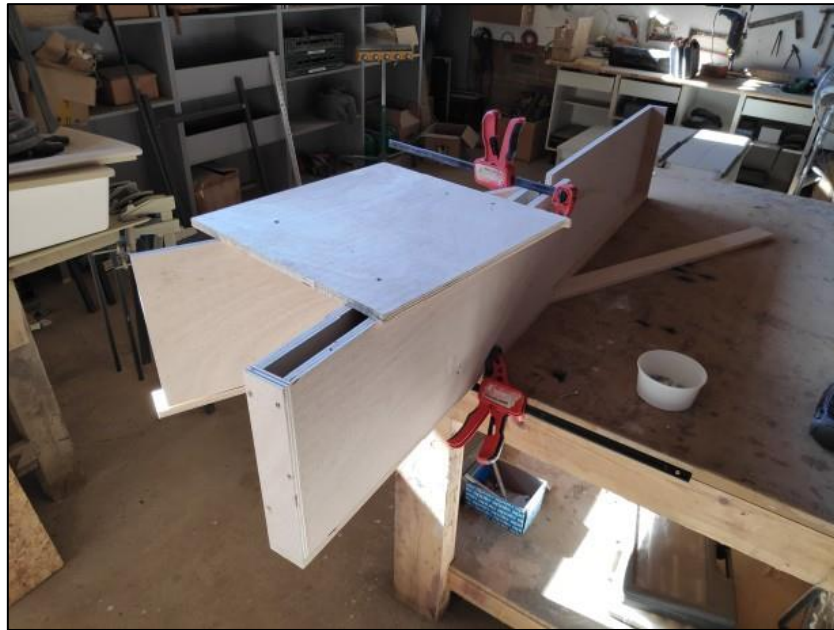
Imatge 20: Muntatge de l'encofrat (3).
