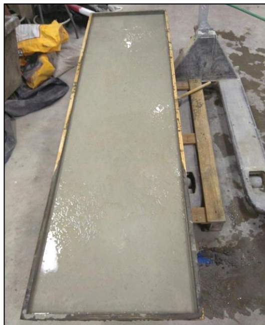
Imatge 35: Prototip amb formigó en estat fresc.
