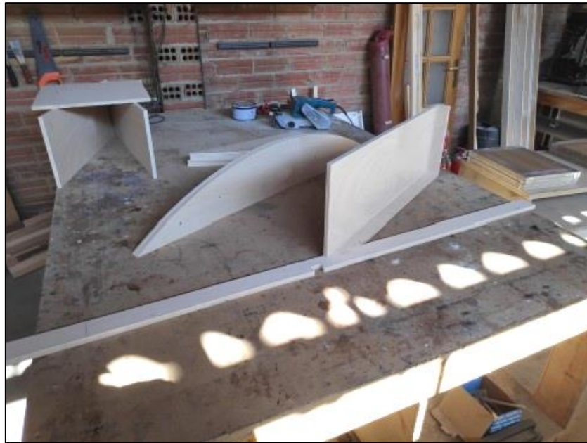
Imatge 18: Muntatge de l'encofrat (1).
