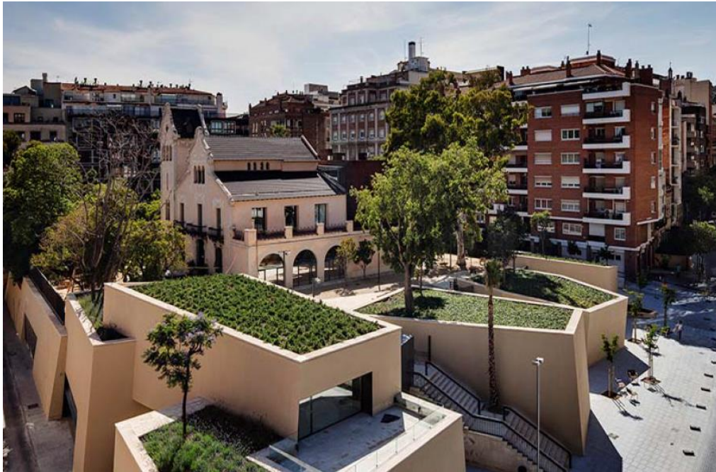
Figura 1-6. Façana de la Biblioteca Sant Gervasi - Joan Maragall, Barcelona (Ajuntament de Barcelona, s.d.).
