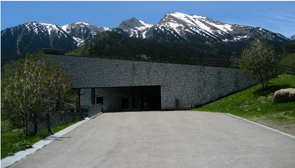
Figura 1-8. Façana lateral (sud) de l'edifici MónNatura Pirineus (Pallars Sobirà). (Estudi FGH, 2009).
